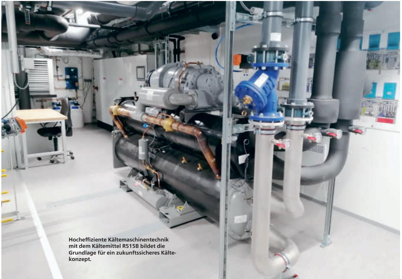
**Hocheffiziente Kältemaschinentechnik mit dem Kältemittel R515B bildet die Grundlage für ein zukunftssicheres Kältekonzept.**
