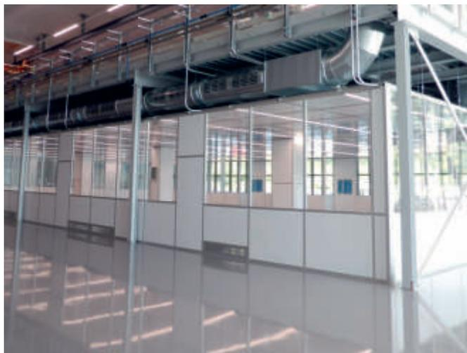
Das modulare Reinraumsystem erlaubte eine einfache Erweiterung im laufenden Betrieb (Bild: Schilling Engineering).
