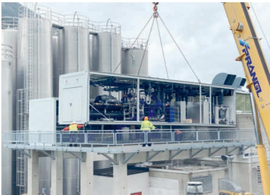
Auf mit Pfeilern abgestützten Fundamenten wurden in luftiger Höhe die drei Module der ONI-Container-Kühlanlage zu einer Einheit zusammengesetzt. Hier wird das zweite Modul der Anlage millimetergenau eingepasst
