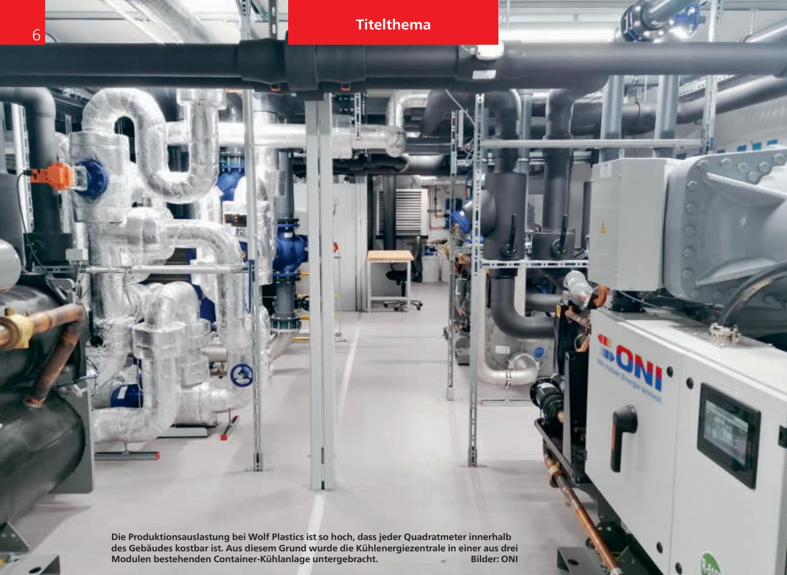
Die Produktionsauslastung bei Wolf Plastics ist so hoch, dass jeder Quadratmeter innerhalb des Gebäudes kostbar ist. Aus diesem Grund wurde die Kühlenergiezentrale in einer aus drei Modulen bestehenden Container-Kühlanlage untergebracht. Bilder: ONI
