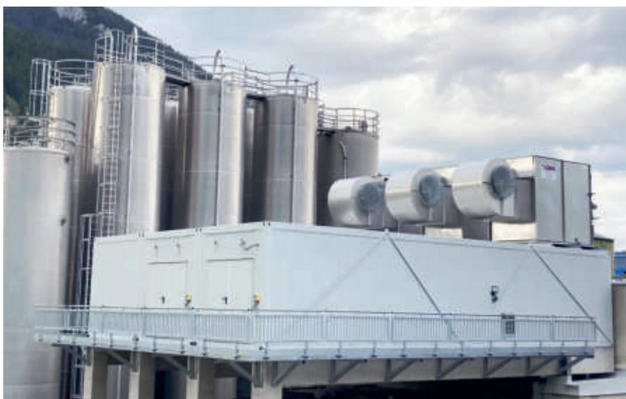
Die komplette Einheit bringt mehr als 300 Tonnen Betriebsgewicht auf die Waage. Zur Aufstellung der drei Rückkühlwerke wurde platzsparend das Dach der Container genutzt.
